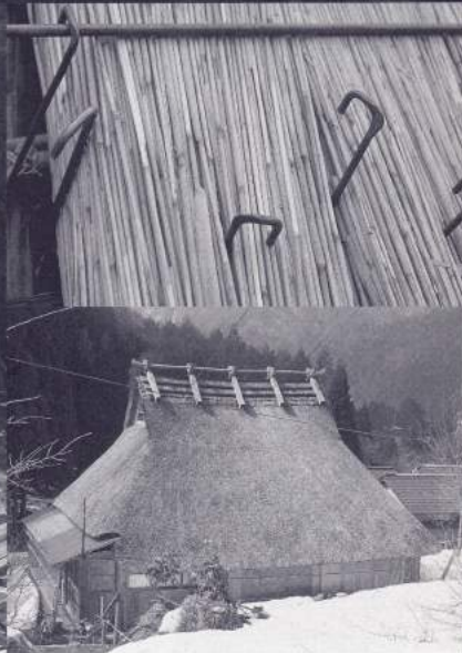
左…佐伯家の葺き替え作業。ハシゴを登っているのがロジャー・エヴァンズさん。英国式の茅葺きは職人1人で葺くことができる。 撮影：安藤邦廣 右…フックと鉄筋。 撮影：安藤邦廣
