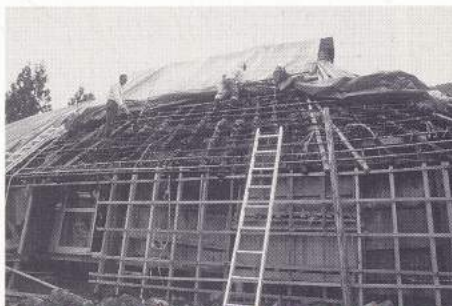
古い茅がすっかり取り払われ、下地だけになった屋根。
