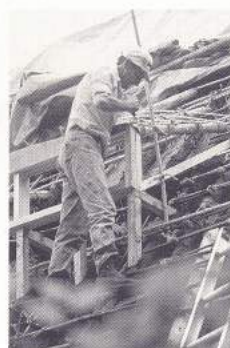
上3点左から／古い茅を取り去った屋根の下地を中から見上げたところ。／後藤さん（右端）が中心となって窓枠を屋根に取り付ける。／窓枠取り付けの準備をする後藤さんと尾坂さん。右写真／取り付けられた窓枠に、葺を葺くための下地をつくるロジャーさん。
