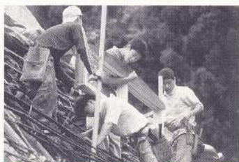
上3点左から／古い茅を取り去った屋根の下地を中から見上げたところ。／後藤さん（右端）が中心となって窓枠を屋根に取り付ける。／窓枠取り付けの準備をする後藤さんと尾坂さん。右写真／取り付けられた窓枠に、葺を葺くための下地をつくるロジャーさん。
