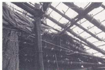
上3点左から／古い茅を取り去った屋根の下地を中から見上げたところ。／後藤さん（右端）が中心となって窓枠を屋根に取り付ける。／窓枠取り付けの準備をする後藤さんと尾坂さん。右写真／取り付けられた窓枠に、葺を葺くための下地をつくるロジャーさん。
