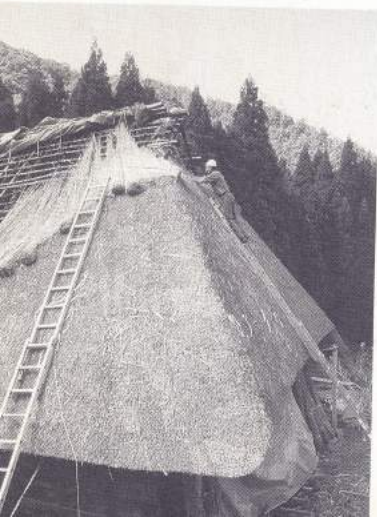
上/同じ道具を使いながら、葺き終わった屋根の仕上げをする。左/作業がすすみ、美しく仕上がっていく屋根。
