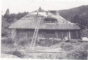
右/葺が簀かれ、かわいらしく仕上がった屋根の小窓。上/小窓の回りに葺が簀かれると、外観の印象もずいぶん変わってきた。日本の茅葺き民家より、軽快なイメージ。
