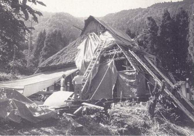
屋根には埃よけと雨よけのために青いシートをかぶせる。
