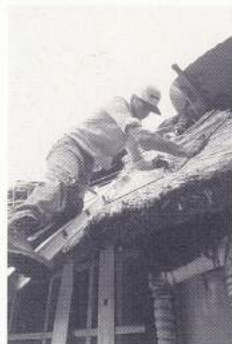
右/並べた葦にスチールのフックを打ち付けていく。上/フックにスチールの押さえ棒をはさみ、葦をしっかりと固定。左/梯子の上で体を斜めにしながらの作業が続けられる。
