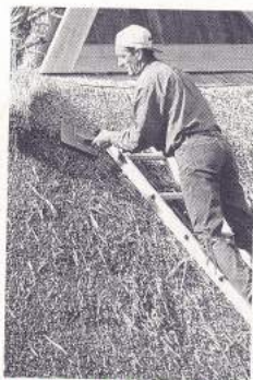
上/同じ道具を使いながら、葺き終わった屋根の仕上げをする。左/作業がすすみ、美しく仕上がっていく屋根。
