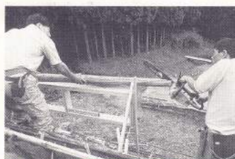
上3点左から／古い茅を取り去った屋根の下地を中から見上げたところ。／後藤さん（右端）が中心となって窓枠を屋根に取り付ける。／窓枠取り付けの準備をする後藤さんと尾坂さん。右写真／取り付けられた窓枠に、葺を葺くための下地をつくるロジャーさん。
