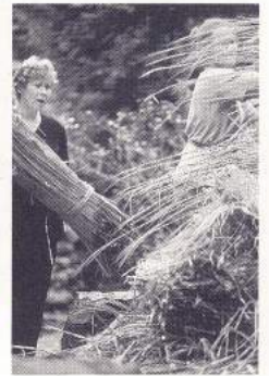
右ページ/作業に入る前の茅葺き屋根。右/降ろした古い茅を積み上げるのに忙しいマギーさんとロジャーさんの夫人のアイリーンさん。上/古い茅は束にし屋根から降ろす。
