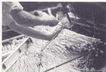
右/並べた葦にスチールのフックを打ち付けていく。上/フックにスチールの押さえ棒をはさみ、葦をしっかりと固定。左/梯子の上で体を斜めにしながらの作業が続けられる。
