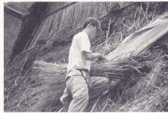
右ページ/作業に入る前の茅葺き屋根。右/降ろした古い茅を積み上げるのに忙しいマギーさんとロジャーさんの夫人のアイリーンさん。上/古い茅は束にし屋根から降ろす。
