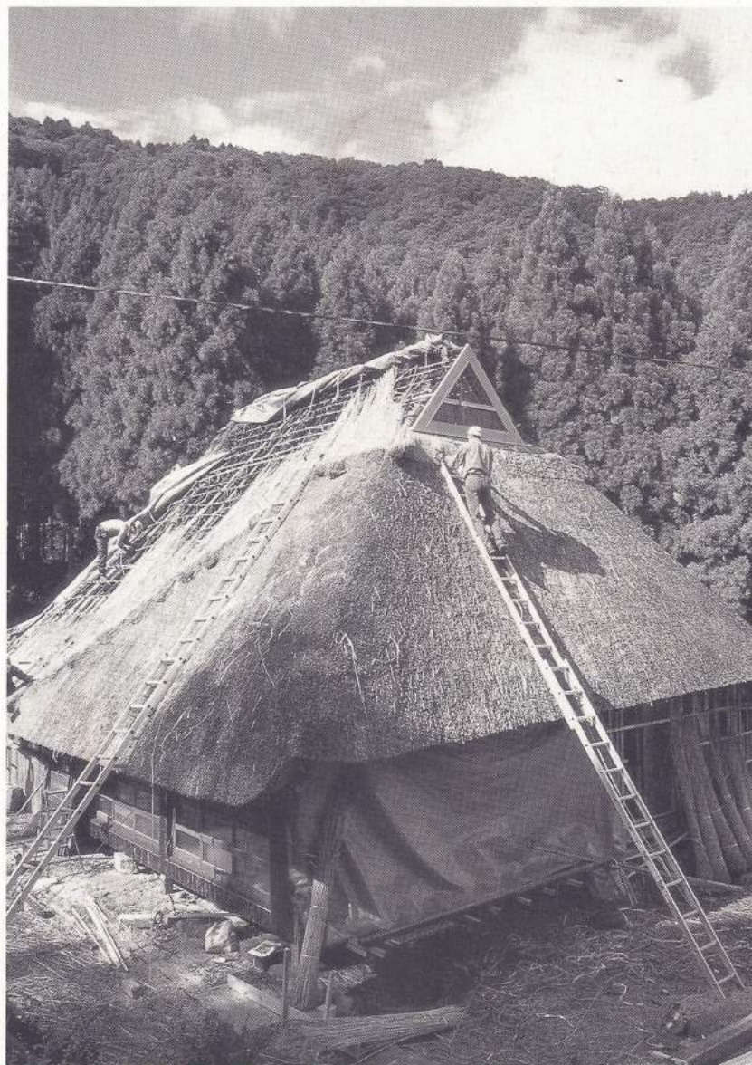
長い梯子の上で、葺を次々と留め付けていくロジャーさん。
