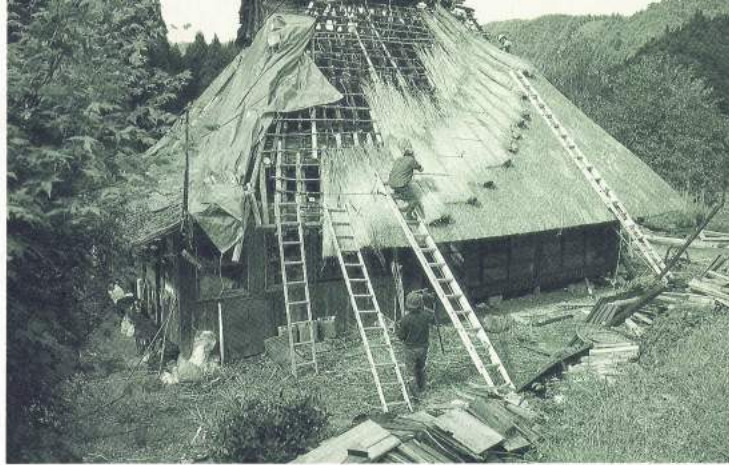
半分ほど新しい葺かされた屋根。
