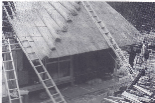
足場よりも、早く簡単に作業が出来る梯子を使う。屋根の棟樑は「Sway」という3mmの鉄棒。
