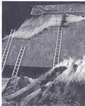
足場よりも、早く簡単に作業が出来る梯子を使う。屋根の棟樑は「Sway」という3mmの鉄棒。
